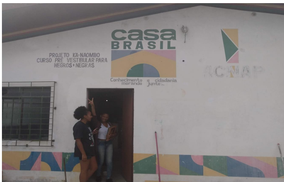
Figura 33: Fachada da sede da ACNAP, registro do mutirão de reforma. Vila Xapinhal, Sítio Cercado, Curitiba- PR, fevereiro/2020.
